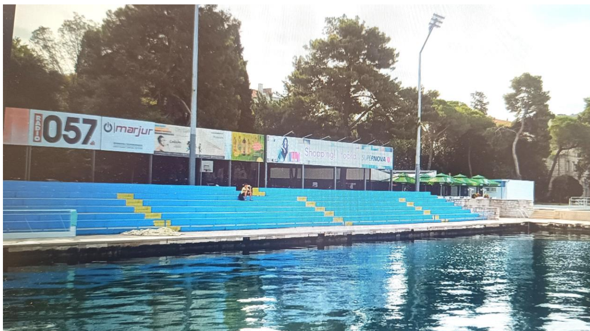
Slika br. 26 Obojane tribine i željezna ograda uz bazen Otvorenog plivališta Kolovare
