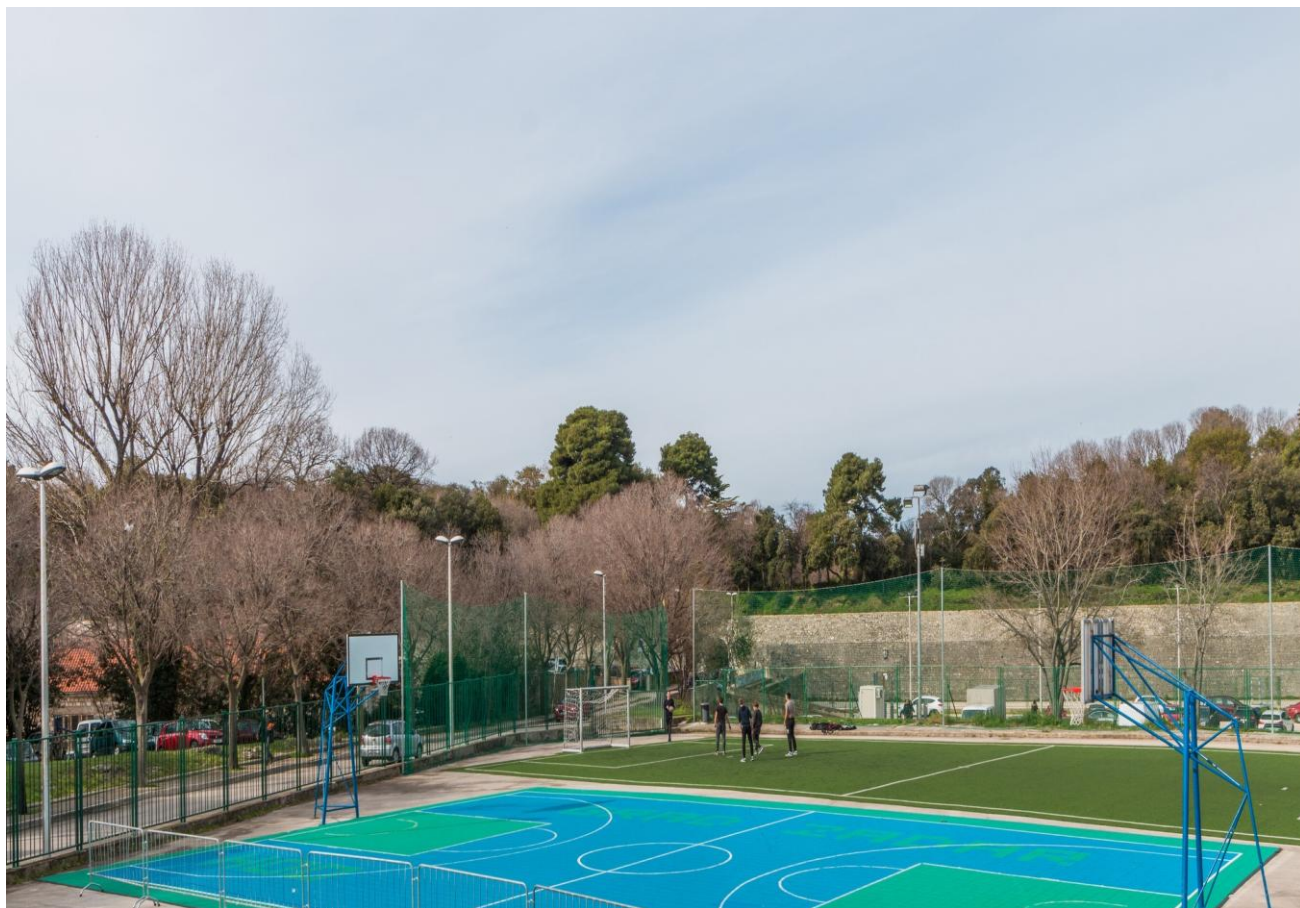
Slika br.3 Rekonstrukcija ograde na ŠRC Ravnice
